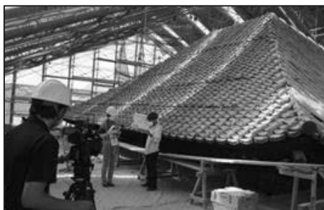
修理現場からのライブ講義（東大寺戒壇堂）
